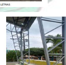
PINTADA DE ESTRUCTURA
