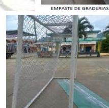
MANTENIMIENTO ARCOS CAMBIO MALLA
