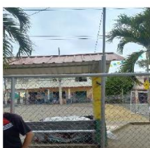
COLOCACIÓN DE TECHO PREPINTADO
