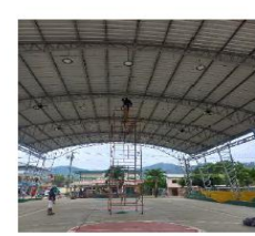
MANTENIMIENTO DE SISTEMA ELÉCTRICO
