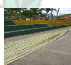
PINTADO DE GRADAS CANCHA
