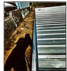
COLOCACION DE CANALÓN DE AGUAS LUVIAS
