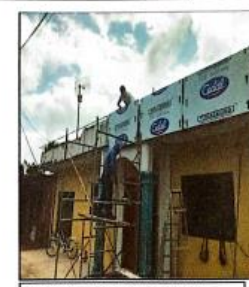
COLOCACION DE ALUCOBOND EN FACHADA PRINCIPAL
