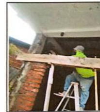
MAMPONTERIA DE LADRILLO AREA DE INFOCENTRO NUEVA
