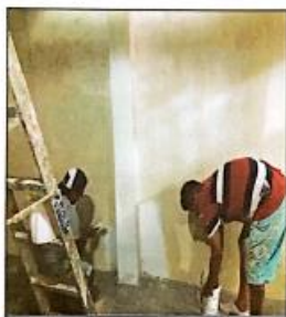
EMPASTADO DE PAREDES INTERIORES
