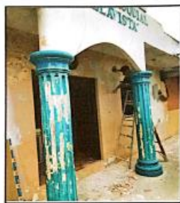
LIJADO DE PAREDES EXTERIORES
