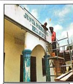
COLOCACION DE PERFILES PARA INSTALACION DE ALUCOBOND EN FACHADA
